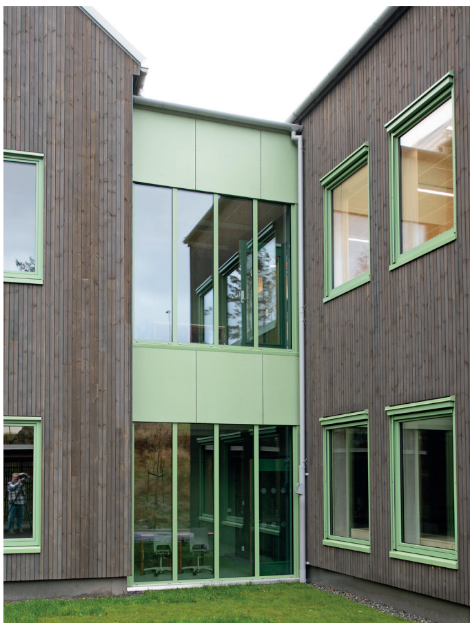
Glassfasade på byggets bakside.
