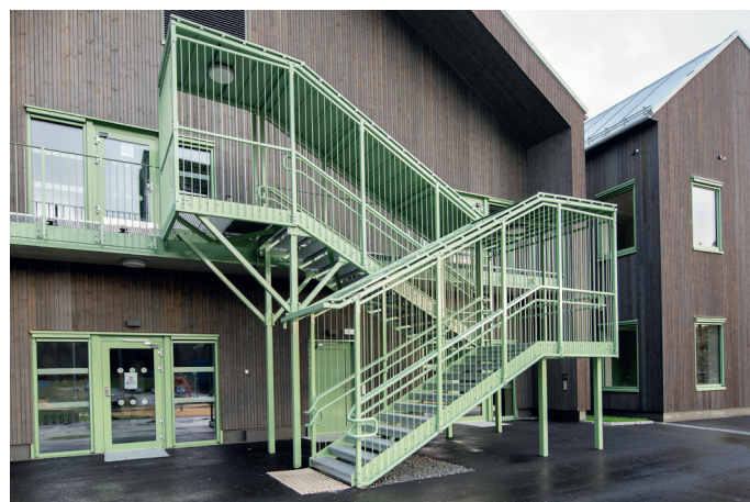
Trapp av stål.
